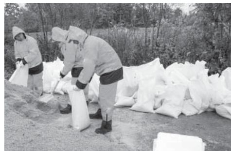
Utrošeno više od 7.000 vreća s pijeskom za utvrđivanje zečjih nasipa
