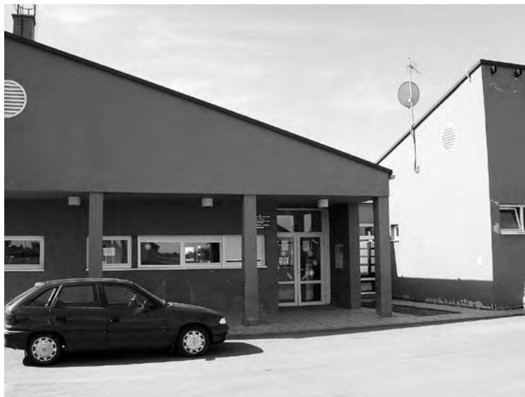
Nužna je obnova pročelja školske zgrade u Budimcima
