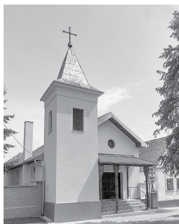
Obnovljeno pročelje kapelice u Razbojištu
