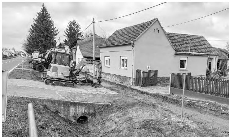
Kompleksni radovi na izgradnji nogostupa
