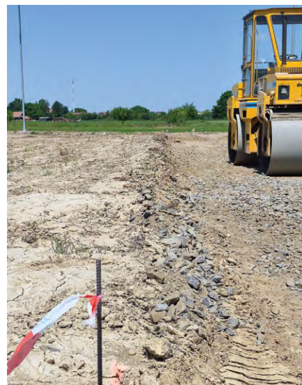
Detalj s gradilišta
