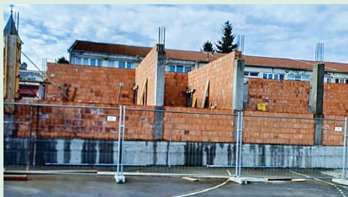
Napreduju radovi na rekonstrukciji i dogradnji OS Hinka Juhna u Podgoraču
