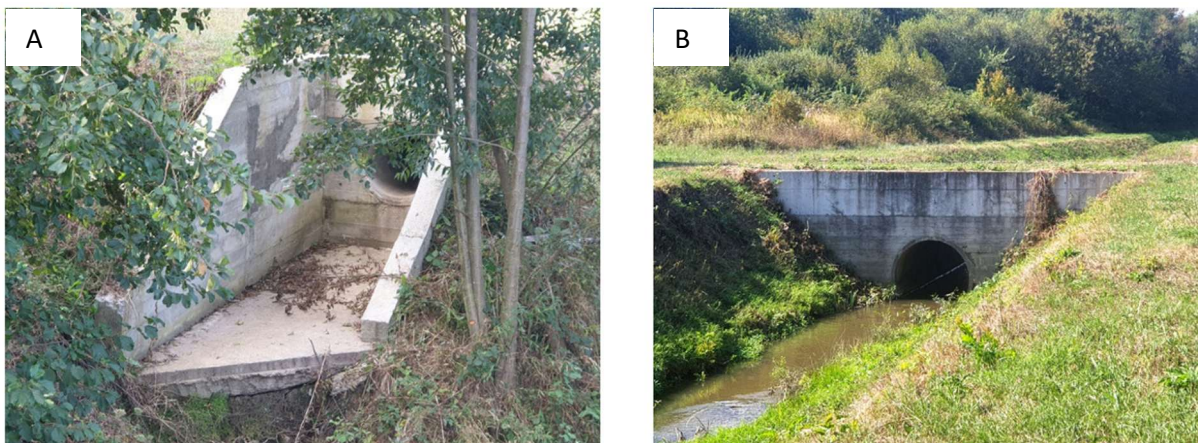
Slika 83. A) Betonska konstrukcija ispusta; B) Betonska konstrukcija prijelaza (Izvor: Sunčana Pešak)
