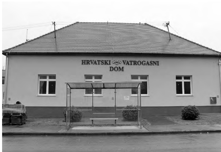
Temeljito je obnovljena zgrada velike dvorane
