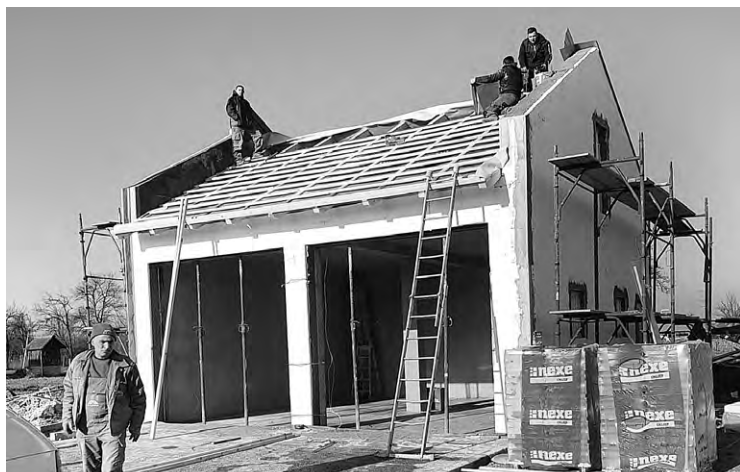
Nakon mjesec dana izgradnje, radovi vidno napreduju
