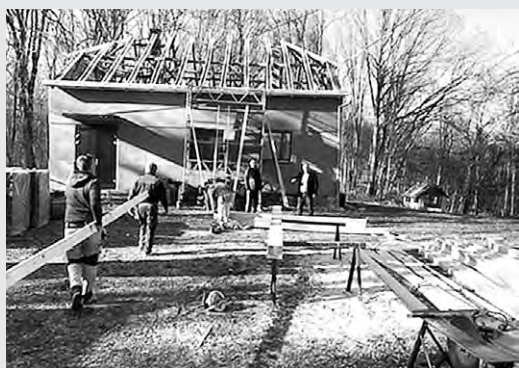
Radovi na obnovi krovišta LD Vepar 1946
