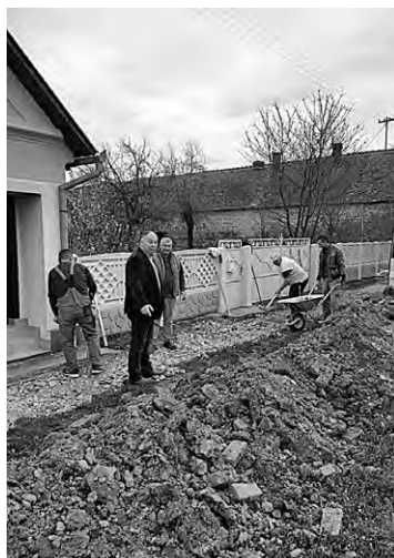
S obilaska radova u Ostrošincima
