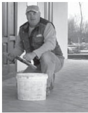
Radnici našičkog Građevinara postavljaju keramičke pločice
