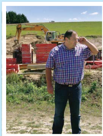
Izgradnja ove retencije spriječit će štete od opasnih poplavnih bujica, kaže načelnik Đanić
