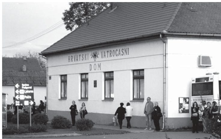
Obavljena je i prva faza rekonstrukcije krova na Vatrogasnom domu u Podgoraču
