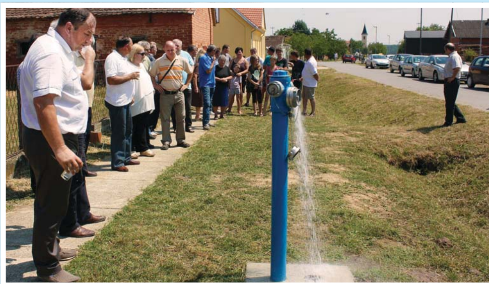
Mještani Kršinaca zadovoljno su promatrali otvaranje vodovoda u svom selu
