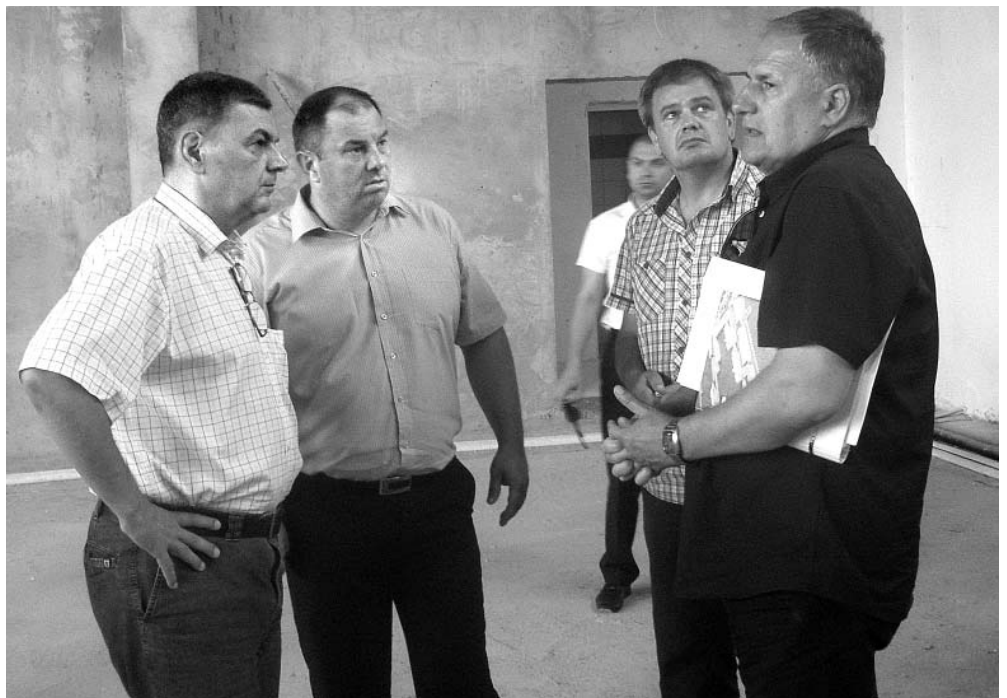
Zajedno s načelnikom Đanićem, župan Šišljagić je obišao radove na izgradnji nastavno-sportske dvorane u Podgoraču
