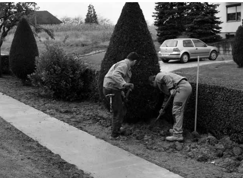
će se nastaviti obnova nogostupa i ozbiljni poslovi na izgradnje kanalizacije
