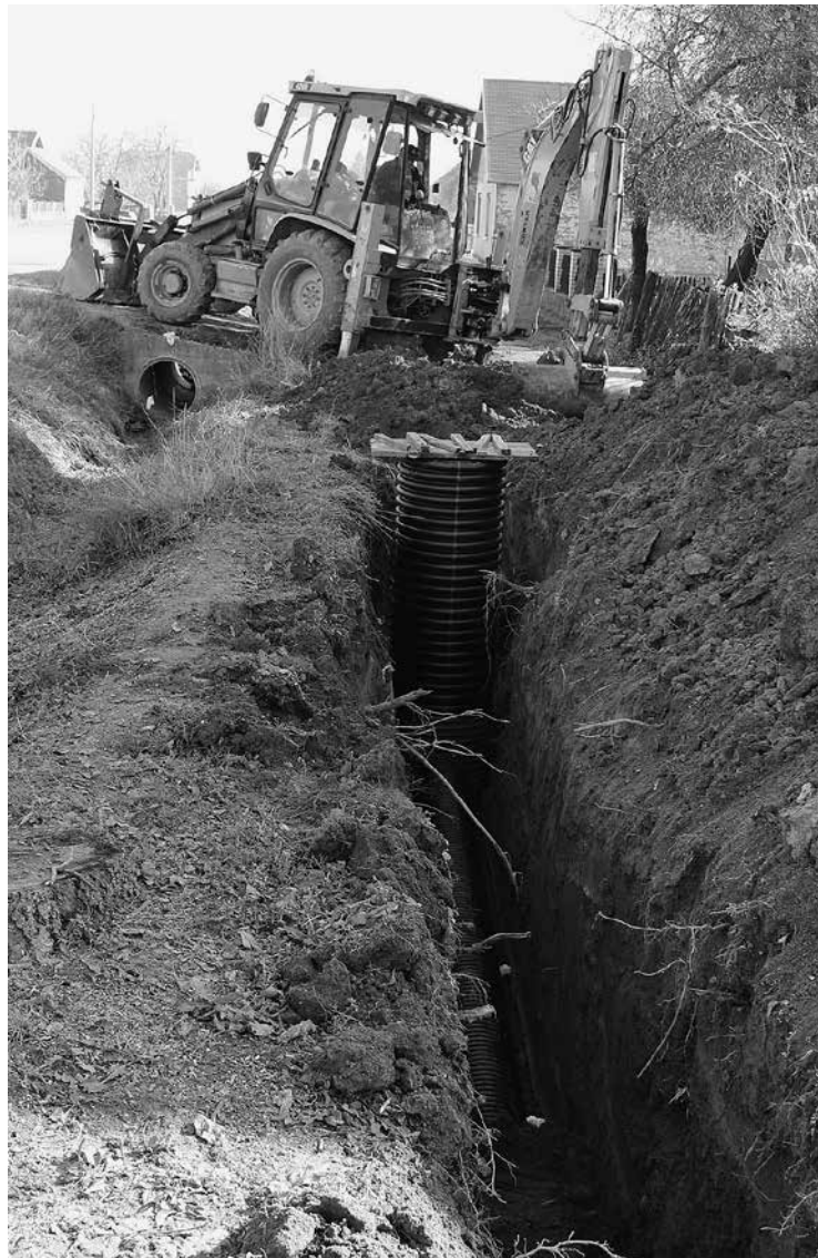
Na nekim dijelovima trebalo je ići i na dva metra dubine
