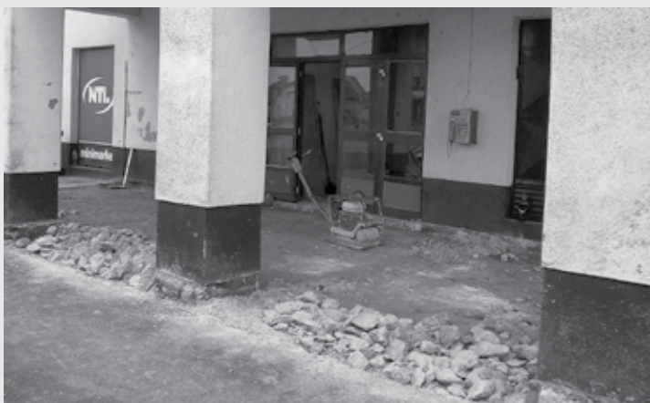
Uređuje se pročelje i izgrađuje prilaz Društvenom domu u Budimcima
