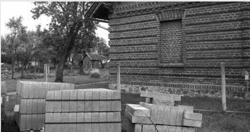
Izgradnja nogostupa do groblja u Kršincima
