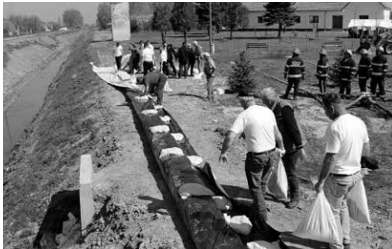
Izgradnja zečjeg nasipa
