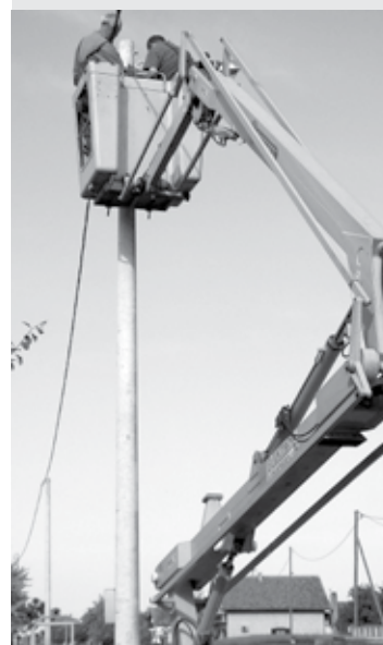
Provedu se radovi na rekonstrukciji niskonaponske elektromreže u Poganovcima
