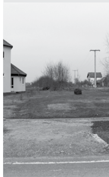
Nakon uređenja središta, u Budimcima su započeli radovi na izgradnju fontane
