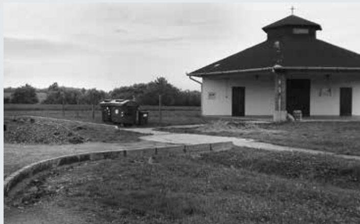
Izgradnja parkirališta kod groblja u Razbojištu
