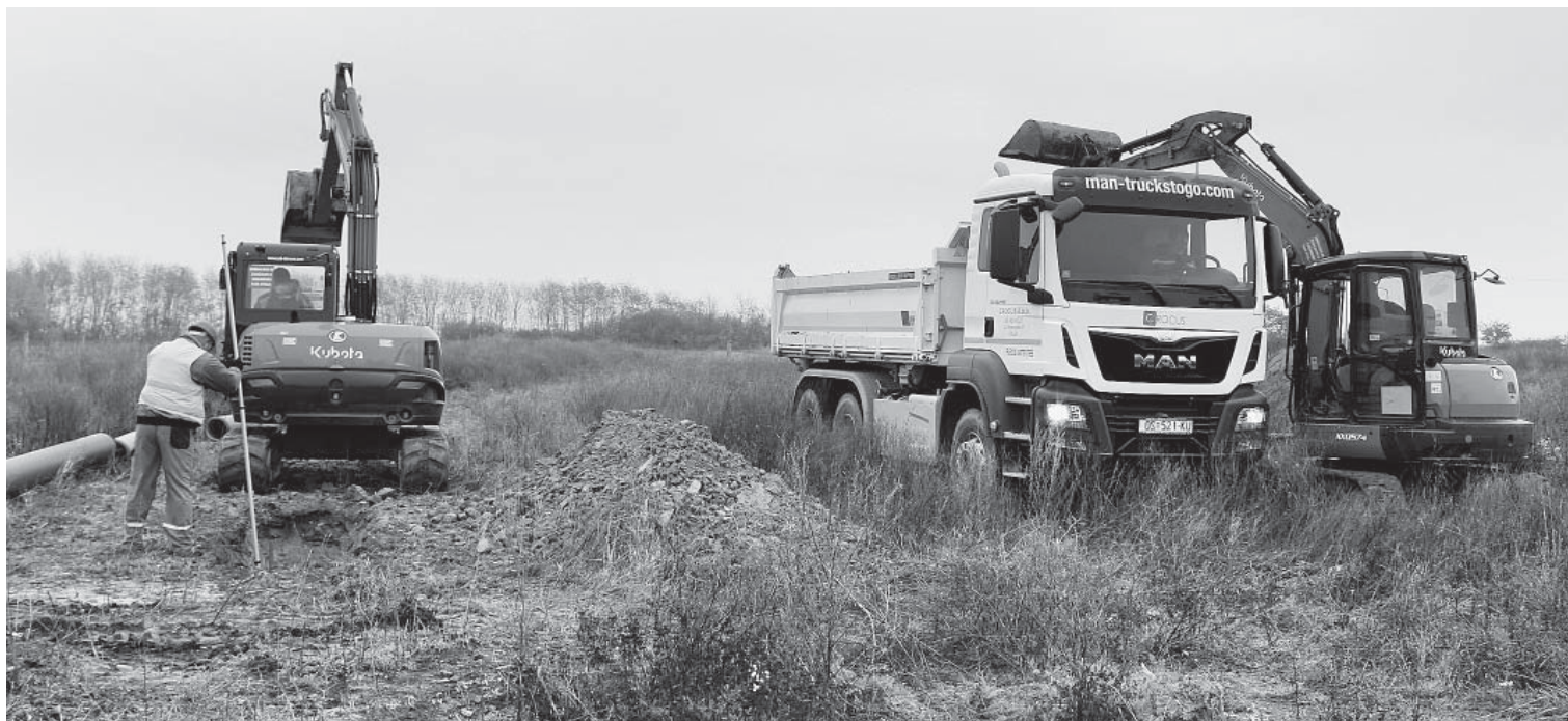
U ovoj fazi je potrebno ugraditi više od dva kilometra vodovodnih i kanalizacijskih cijevi i pratećih dijelova toga sustava
